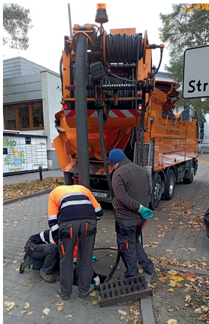
zdj. czyszczenie studni chłonnych
