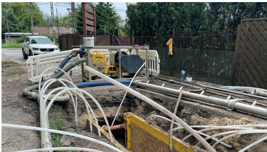
zdj. budowa kanalizacji w ul. Jodłowej w Mościskach
